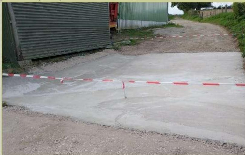
La réalisation d'un espace bétonné complété par la pose d'une bordure permet désormais de détourner l'eau qui ruisselle dans un fossé.
