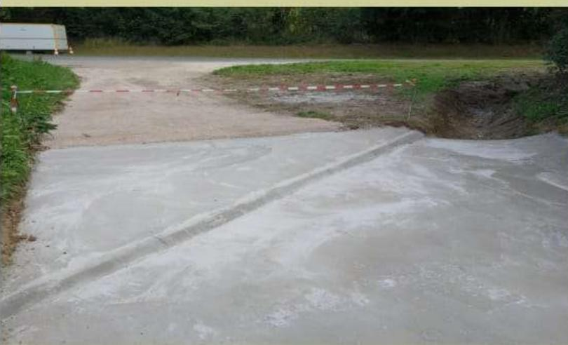
Un ouvrage qui en outre a été conçu pour résister dans le temps aux passages d'outils agricoles et limiter le ravinage du chemin.
